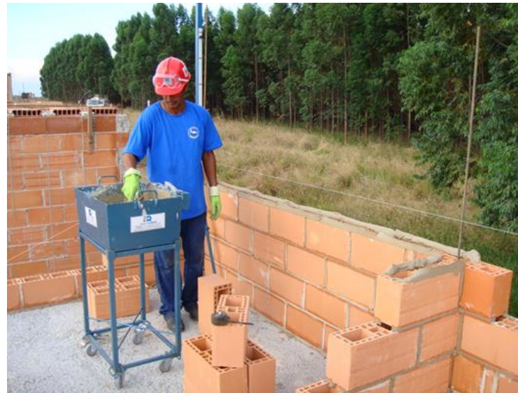
ASSENTAMENTO DOS BLOCOS/COLOCAÇÃO DA ARGAMASSA NOS BLOCOS
