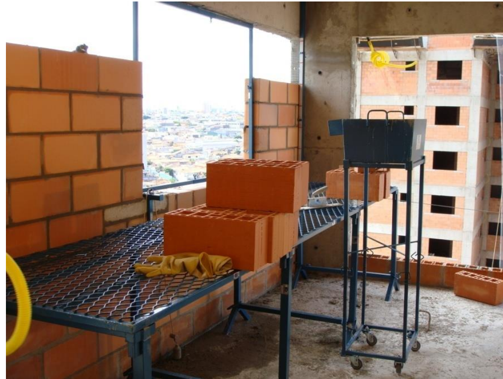
Andaimes – Carrinho de argamassa – Caixa da argamassa – Gabarito de Caixilho
