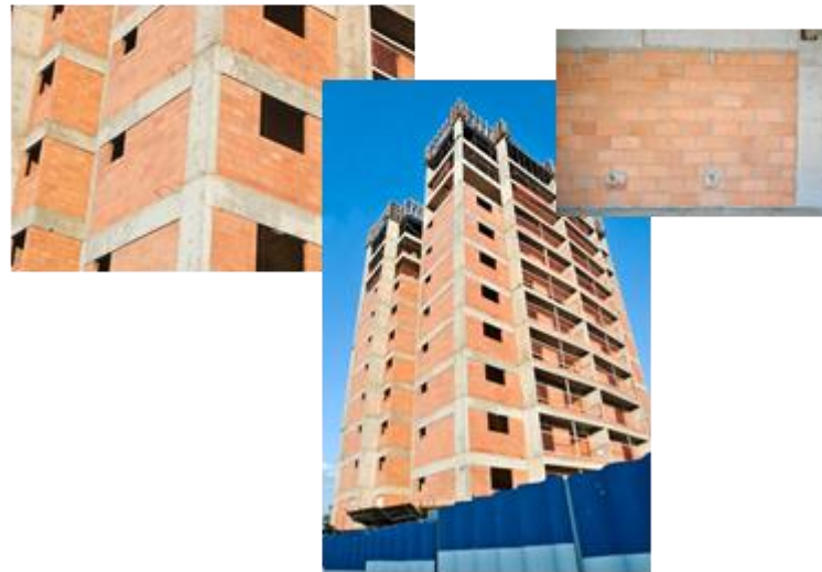
ALVENARIA DE VEDAÇÃO
