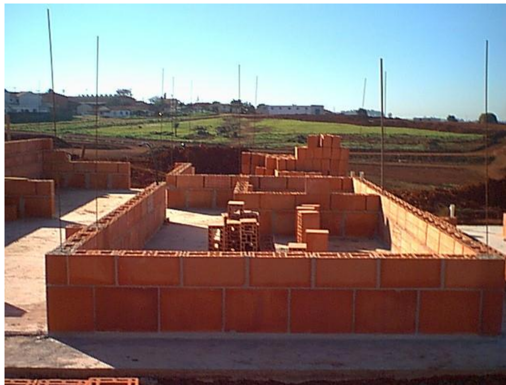
Assentamento da segunda fiada
